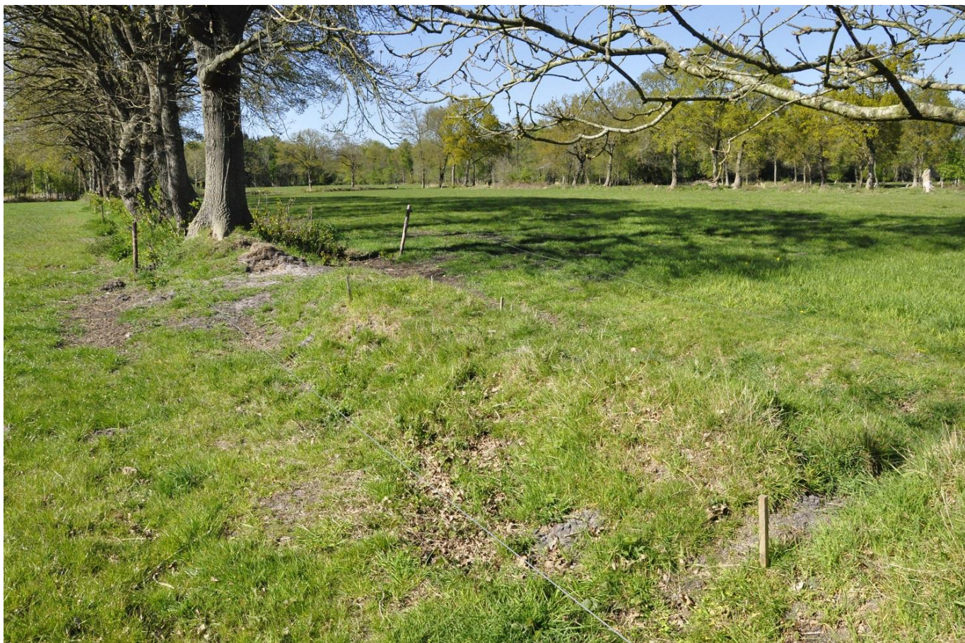
Locatie Mildam. Deel B. Foto 29 april 2026. (Vrijwel) geen aangeplant bosplantsoen meer terug te vinden in dit deel van de houtwal. Net voor de zware eik is de grote beschadiging van het wallichaam te zien.
